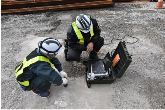
床板鉄筋探査・探査装置
