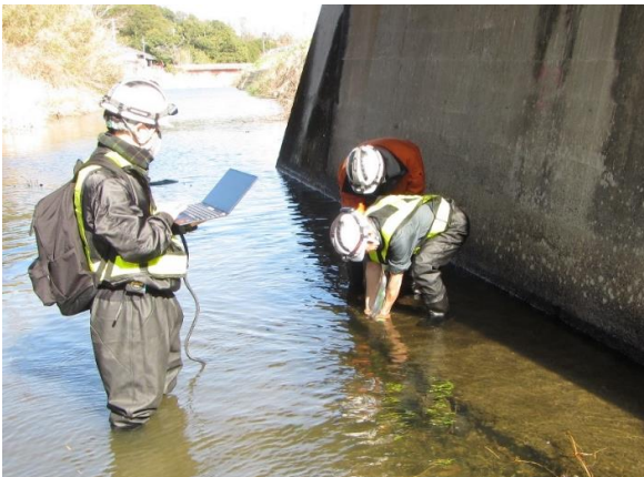
橋脚根入れ深さ探査(水中)
