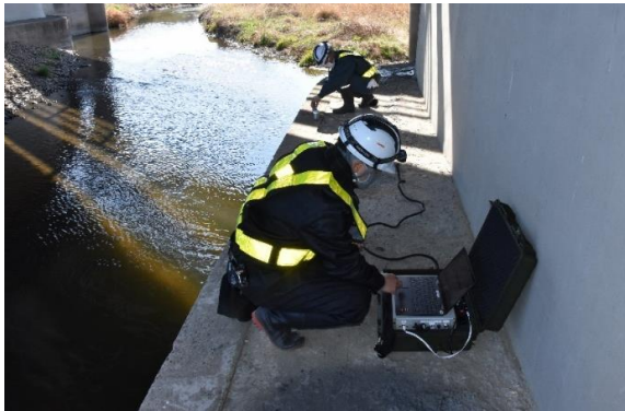
橋脚根入れ深さ探査
