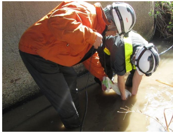
橋脚根入れ深さ探査(水中)
